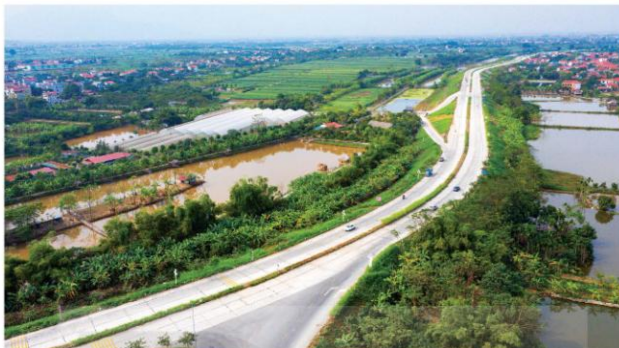
▲ Hình 5. Một đoạn đê sông Hồng
