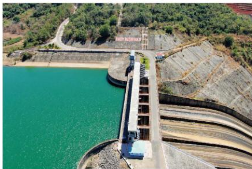
▲ Hình 12. Nhà máy thủy điện laly (tỉnh Gia Lai)
