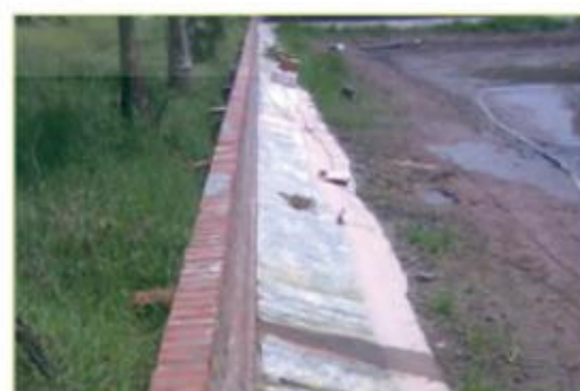
d) Ao nổi, kê bờ
