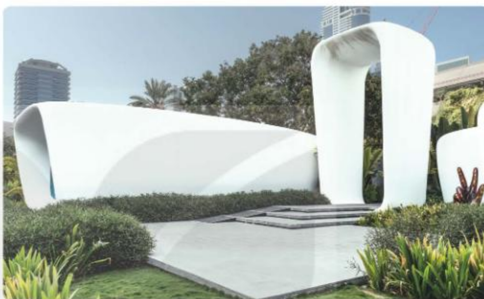
Hình 10. Một phần toà nhà ở Đu-bai (Các Tiểu vương quốc A-rập Thống nhất) được xây dựng bởi máy in 3D
