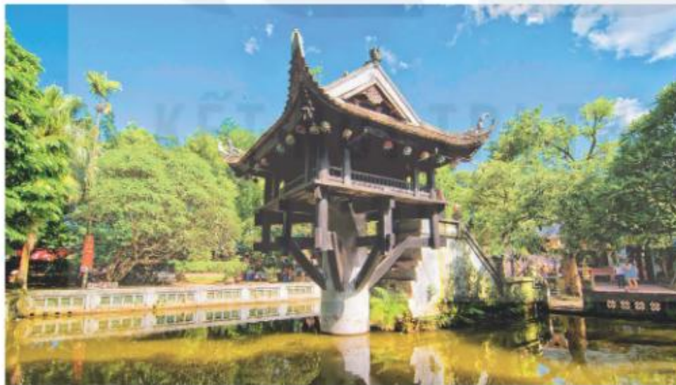
Hình 8. Chùa Một Cột (thành phố Hà Nội) – ngôi chùa được khởi dựng từ thời Lý
